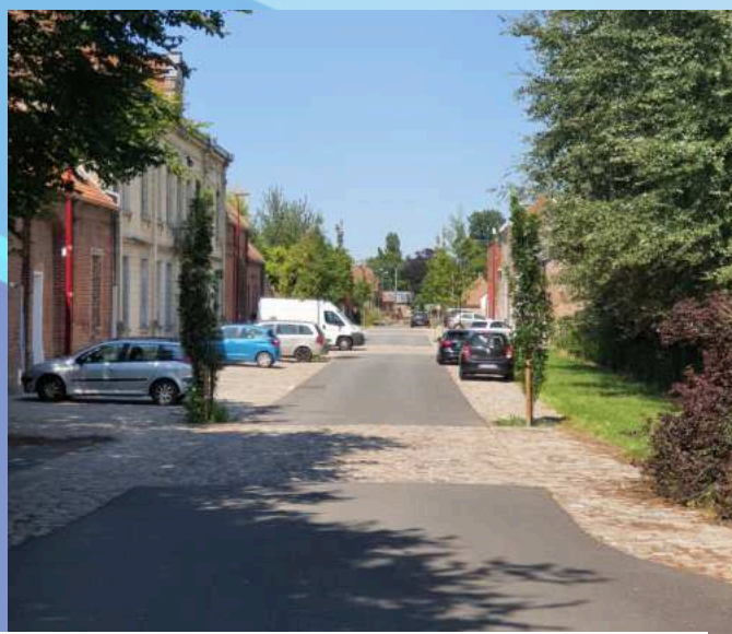
Travaux de rénovation et d'amélioration qualitative de la rue du 11 novembre
