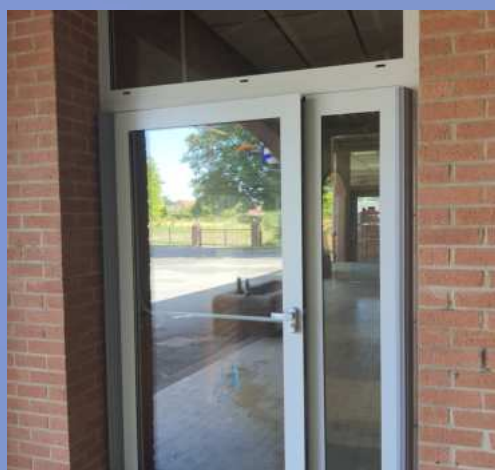
Remplacement d'une double porte à l'école
