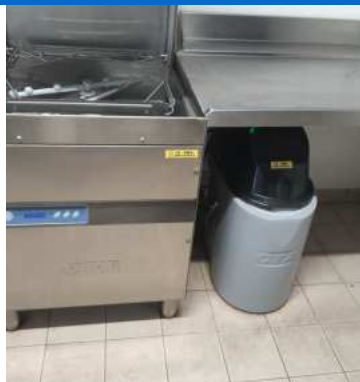
Remplacement de l'adoucisseur à la salle des fêtes
